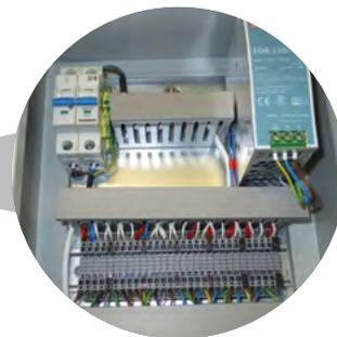
包含主 AC/DC 电源装置、安全开关及用于连接按钮控件与计时器主体的接线端子。
